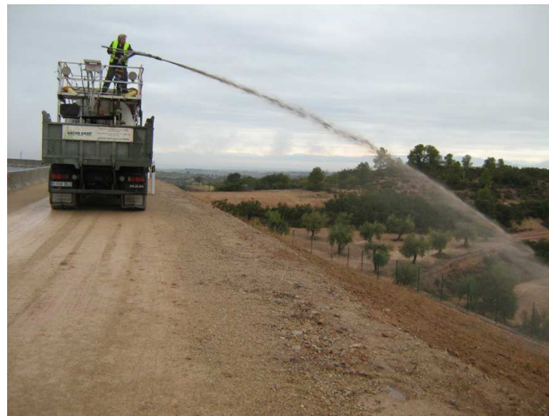
Hidrosiembra de taludes
